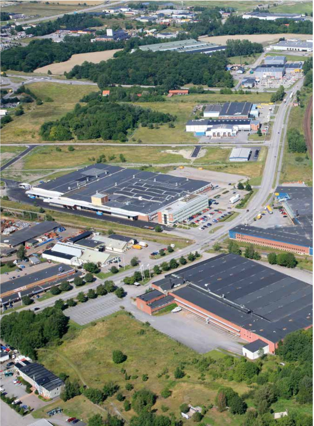
Statorn 31, Norrköping. En av de fastigheter som Catena förvärvade av Kilenkryset i december.
