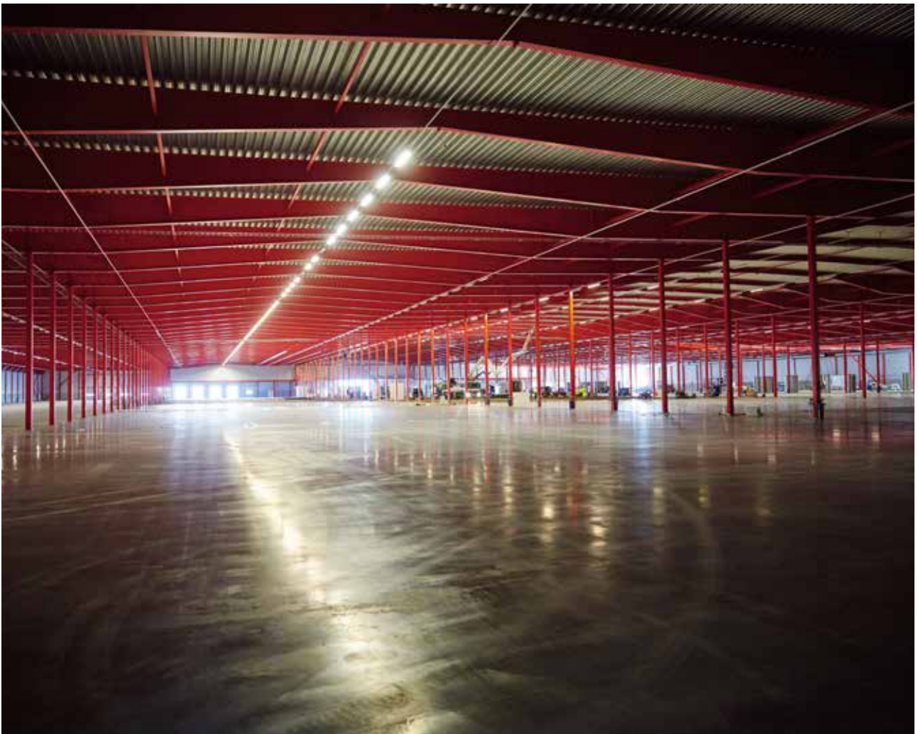
Projektutveckling är för Catena ett prioriterat sätt att växa. Bilden visar slutskedet av en av utbyggnadsetapperna i Norra Varalöv utanför Ängelholm.
