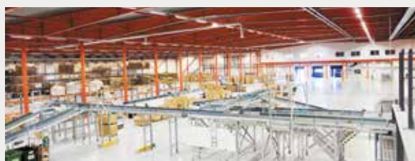
Åt Boozt Fashion AB färdigställde Catena etapp II av nybyggnationen på fastigheten Norra Varalöv 31:11 – E-City Engelholm.
