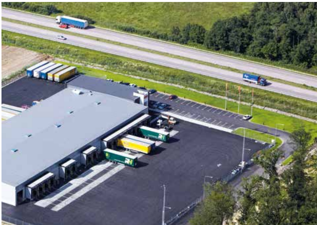
Plantehuset 1, en Logistikposition utanför Helsingborg, strategisk placerad längs E6 och E4.
