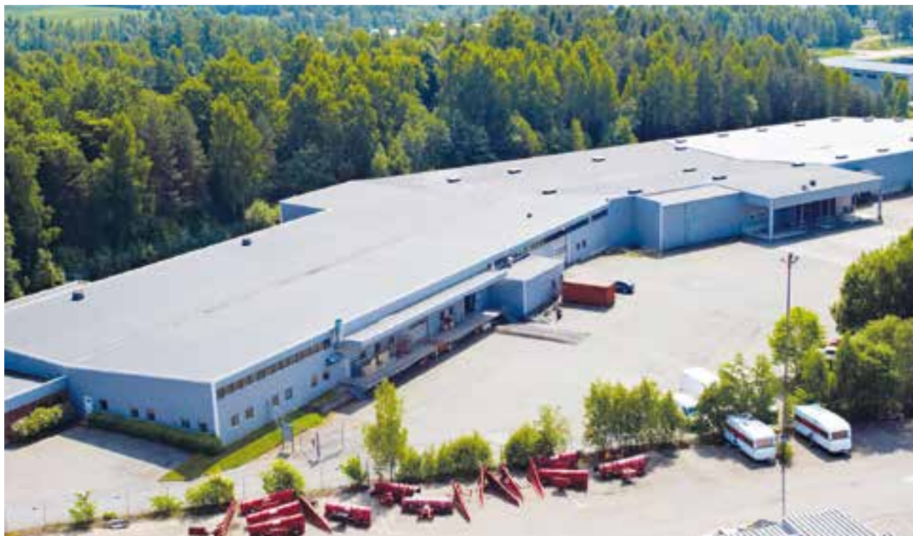
Logistiklagret Ättehögen 2 i Jönköping utrustades under året med en bergvärmeanläggning som reducerar såväl kostnader som miljöpåverkan.
